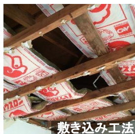
敷き込み工法
